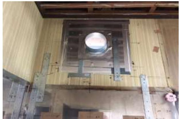
ただ、耐火ボードのない状態での火の取り扱いは危険なので直ちに5mm 厚のケイカル板を貼りました。ケイカル板は重く割れやすいので大工の七つ道具？ 天板押さえ棒？ を使用、これは優れもの。棒の下部はバネで可動式。
