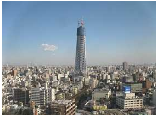
建設中の東京スカイツリー(2010年1月)
